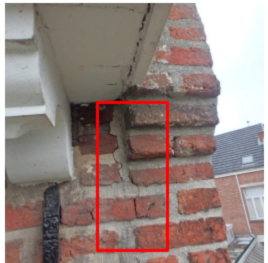
vleugel [1]-zuid: lichte zettingsscheur
