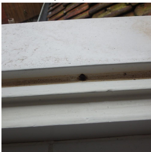
dichtgeslibd condensgaatje
