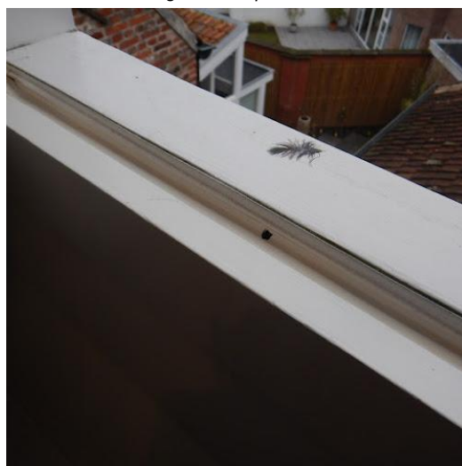
dichtgeslibd condensgaatje
