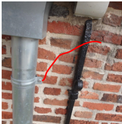
vleugel [1]-zuid: lichte zettingsscheur
