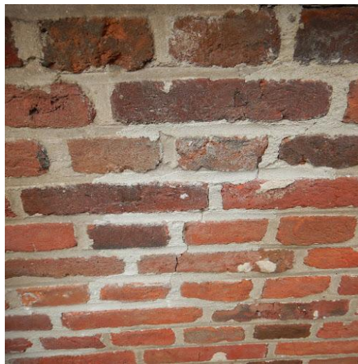
vleugel [1]-zuid: lichte zettingsscheur
