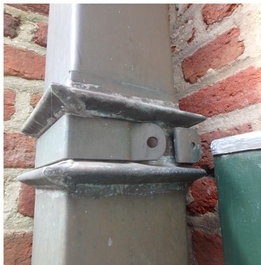
vleugel [2]-oost: afvoerbeugel zit los
