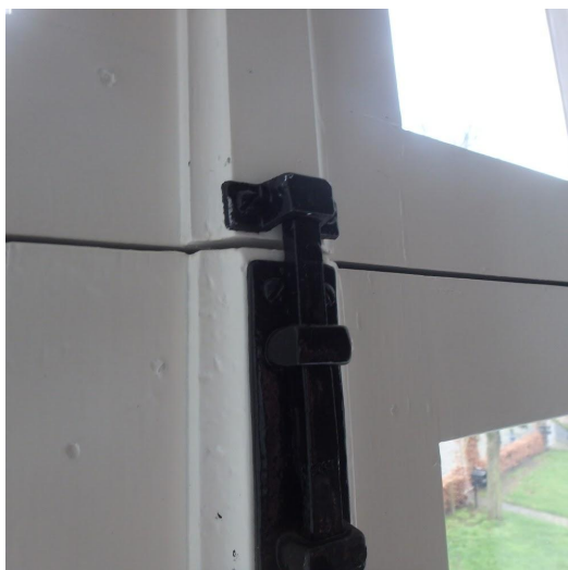
sluitsysteem is vast geschilderd
