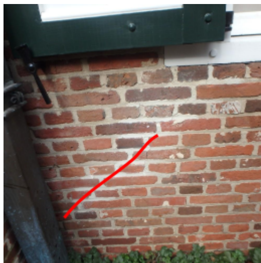
vleugel [2]:differentiele zettingsscheur
