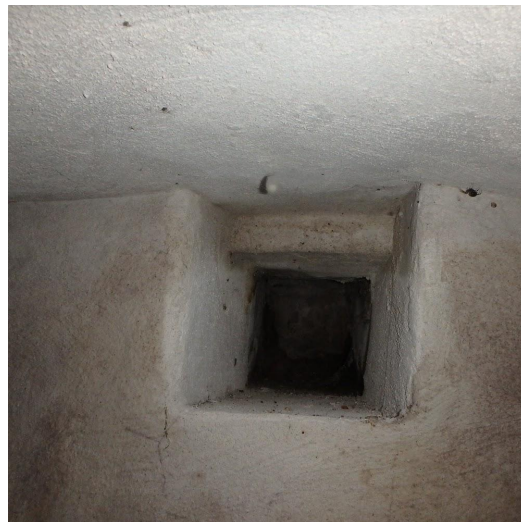
1 verluchting is te weinig voor een goede luchtdoorstroming
